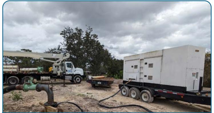
Pruebas de flujo de agua en el campo de pozos para la Tubería Principal de Agua de Transmisión Sureste.
